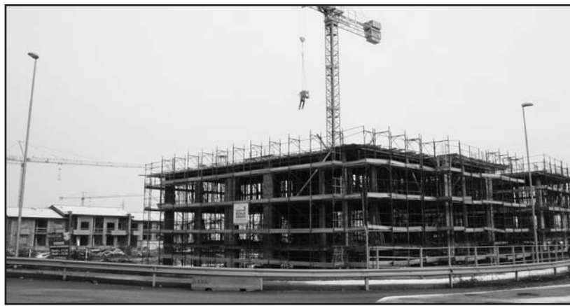
Numerosi i cantieri a Montichiari.
